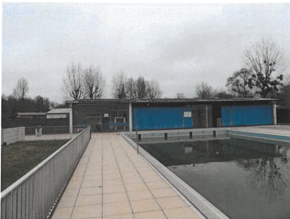
Photo du bassin et du bâtiment
